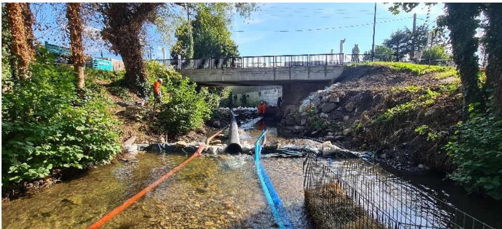
Vue du Chantier le 29-09-2025 lors d'une reprise de sauvetage post coup d'eau et batardage
