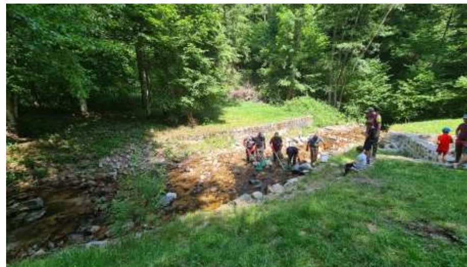
Site de Londoyant suivi en 2025 pots dérèglement du seuil de l'ancien décanteur de la Tâche, travaux réalisés en 2022, photo FDPPMA42
