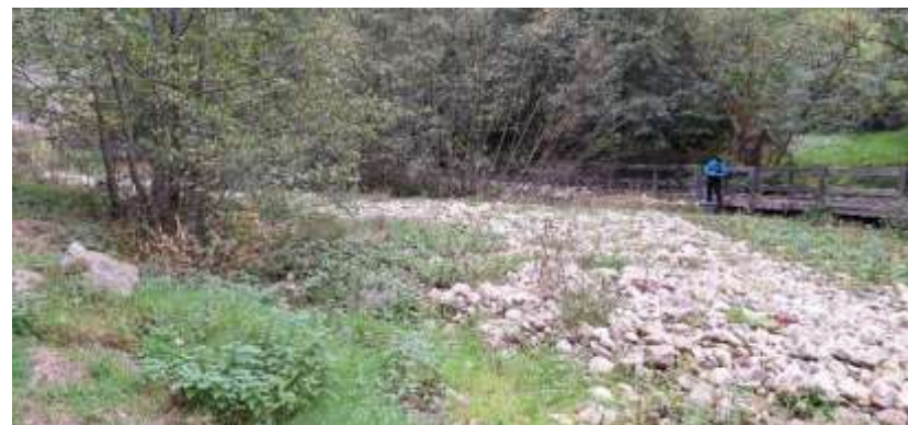
Le Dorlay en amont immédiat du barrage de Doizieux lit totalement détruit et engravé post crue d'octobre 2024
