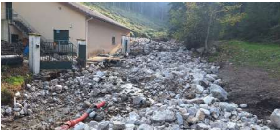
Le Gâ après la crue d'octobre 2024
