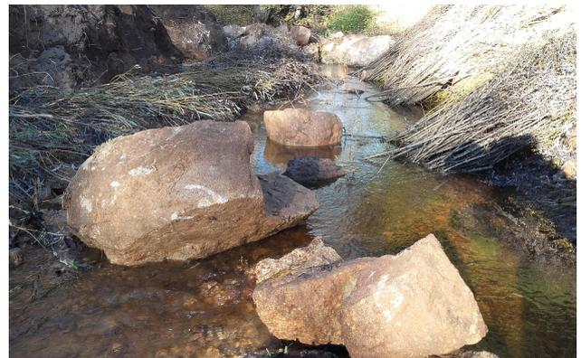
Disposition des blocs dans le chenal
