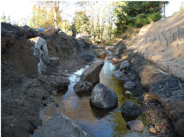
Disposition des blocs dans le chenal
