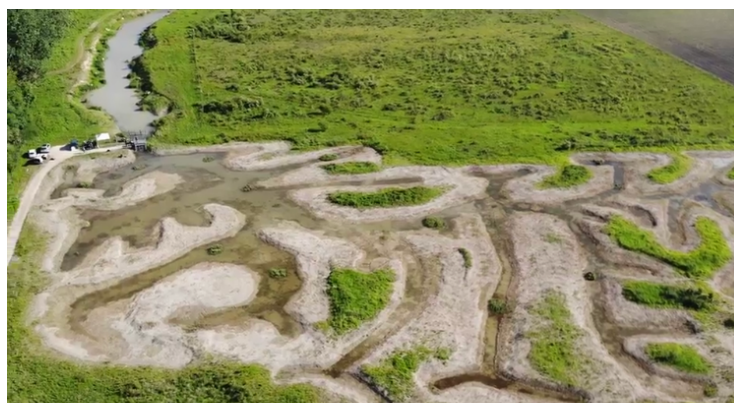
Image 3 : Exemple de travaux de restauration d'une frayère à Brochet sur l'Oise avec création d'une succession de petits bras annexes (Hydrosphère)
