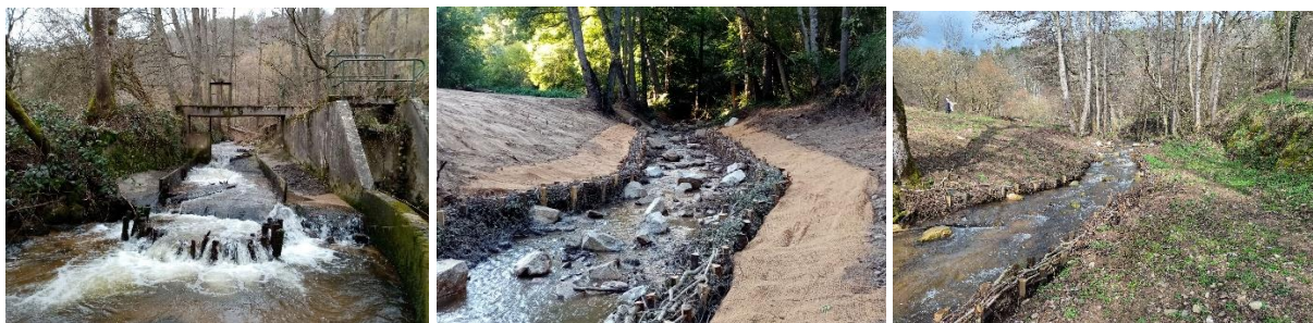
Photos avant travaux, juste après les travaux et 8 mois après travaux
