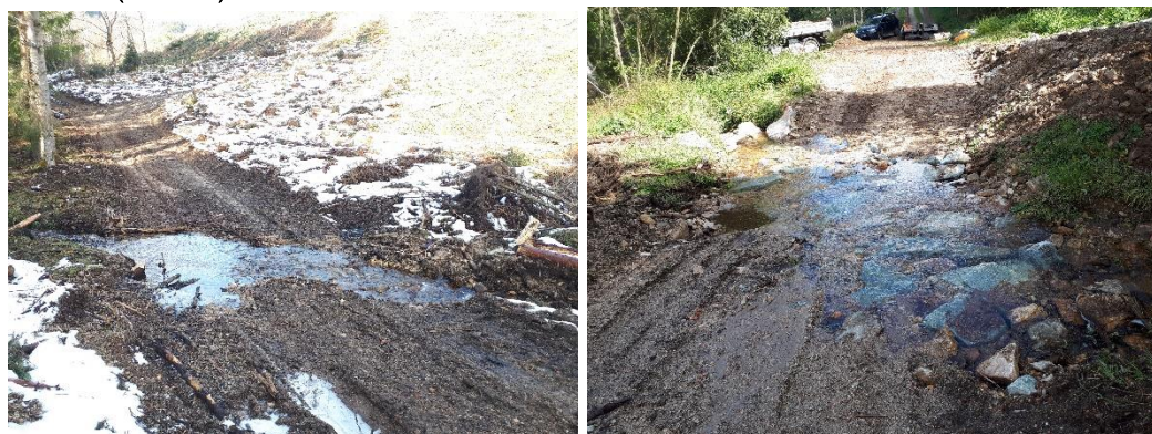
Photos avant et après travaux
