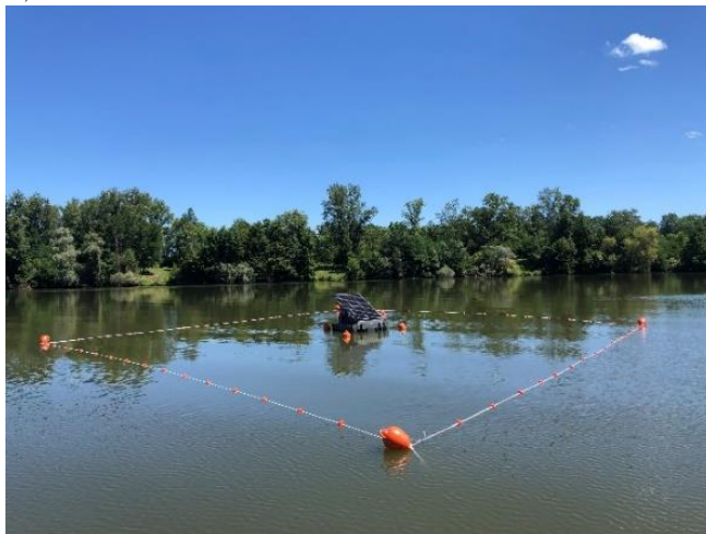
Aérateur avec capteur solaire installé à Cornillon et fonctionnel durant l'été 2023
