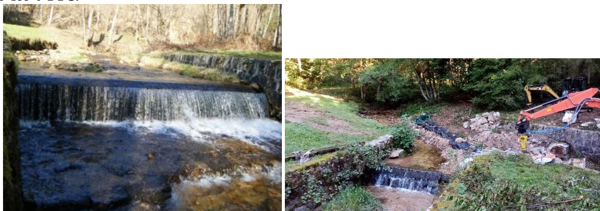
Photos avant et pendant les travaux
