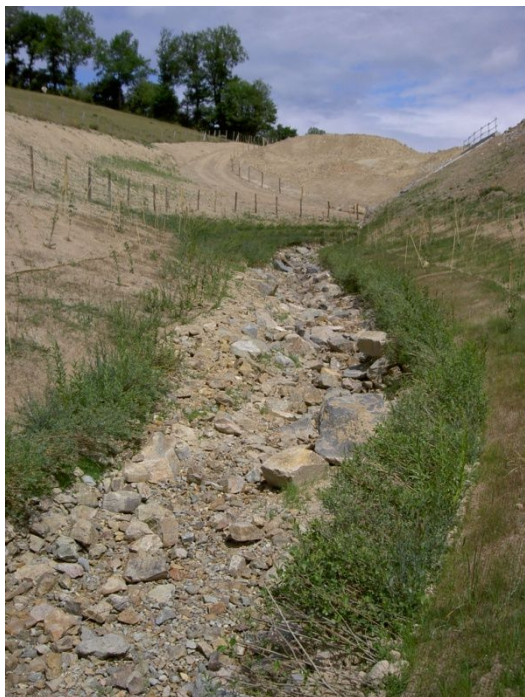
Deux photos de mai 2011 avec visualisation de la rupture d'écoulement dans le lit rescindé avant son colmatage par les éléments fins naturels (FDPPMA42)
