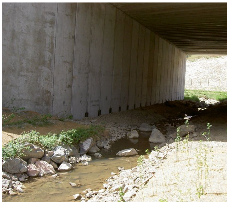
Deux photos de mai 2011 avec visualisation de la rupture d'écoulement dans le lit rescindé avant son colmatage par les éléments fins naturels (FDPPMA42)
