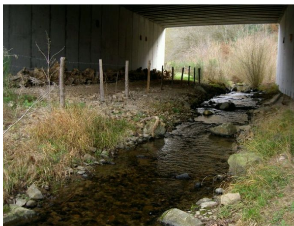
Deux photos de février 2016 avec visualisation du bon d'écoulement dans le lit rescindé et la bonne végétalisation des berges (FDPPMA42)
